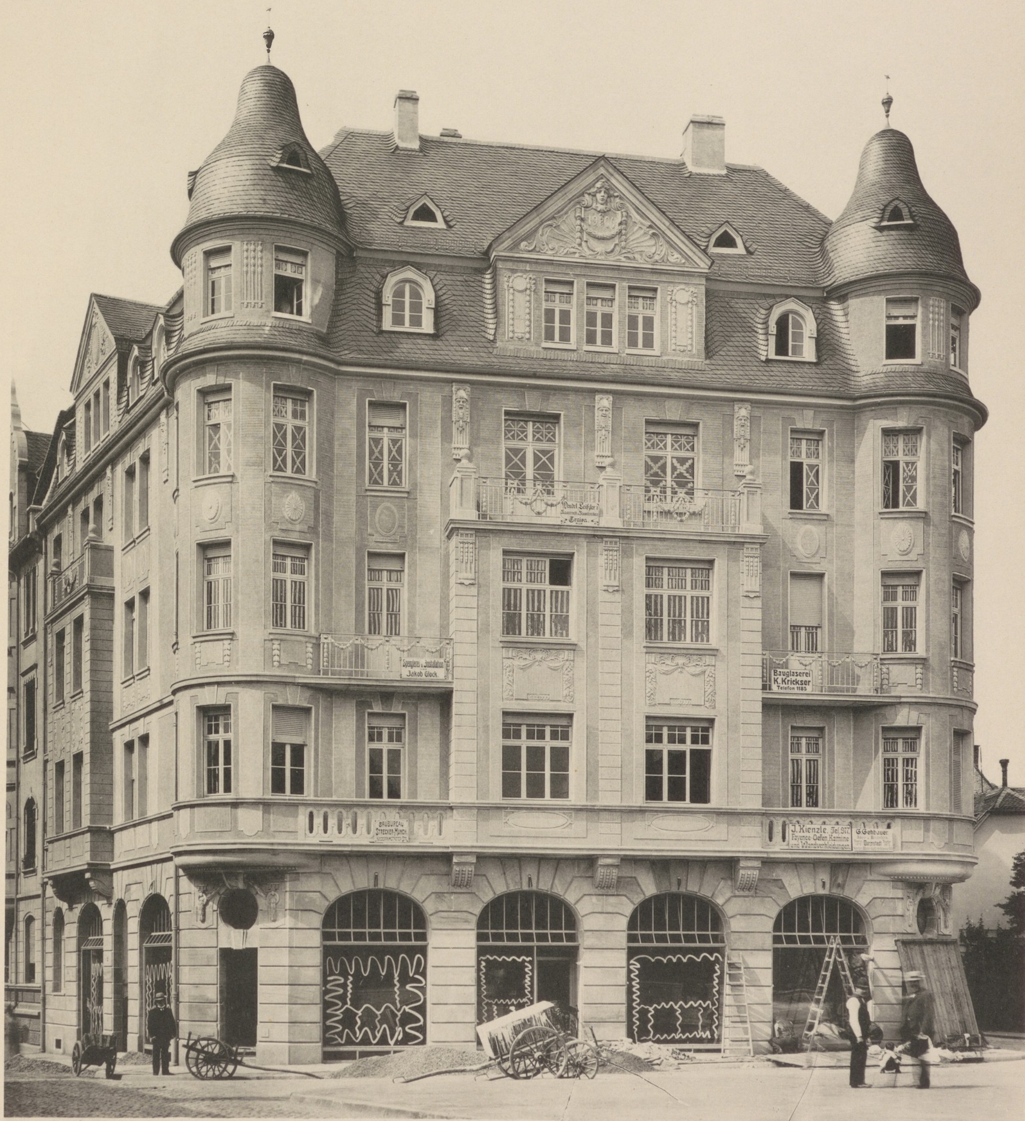
Architekten Strecker & Münch u. Prof. Wickop Wohn- und Geschäftshaus in Darmstadt, Schlossgartenstr. 5.
