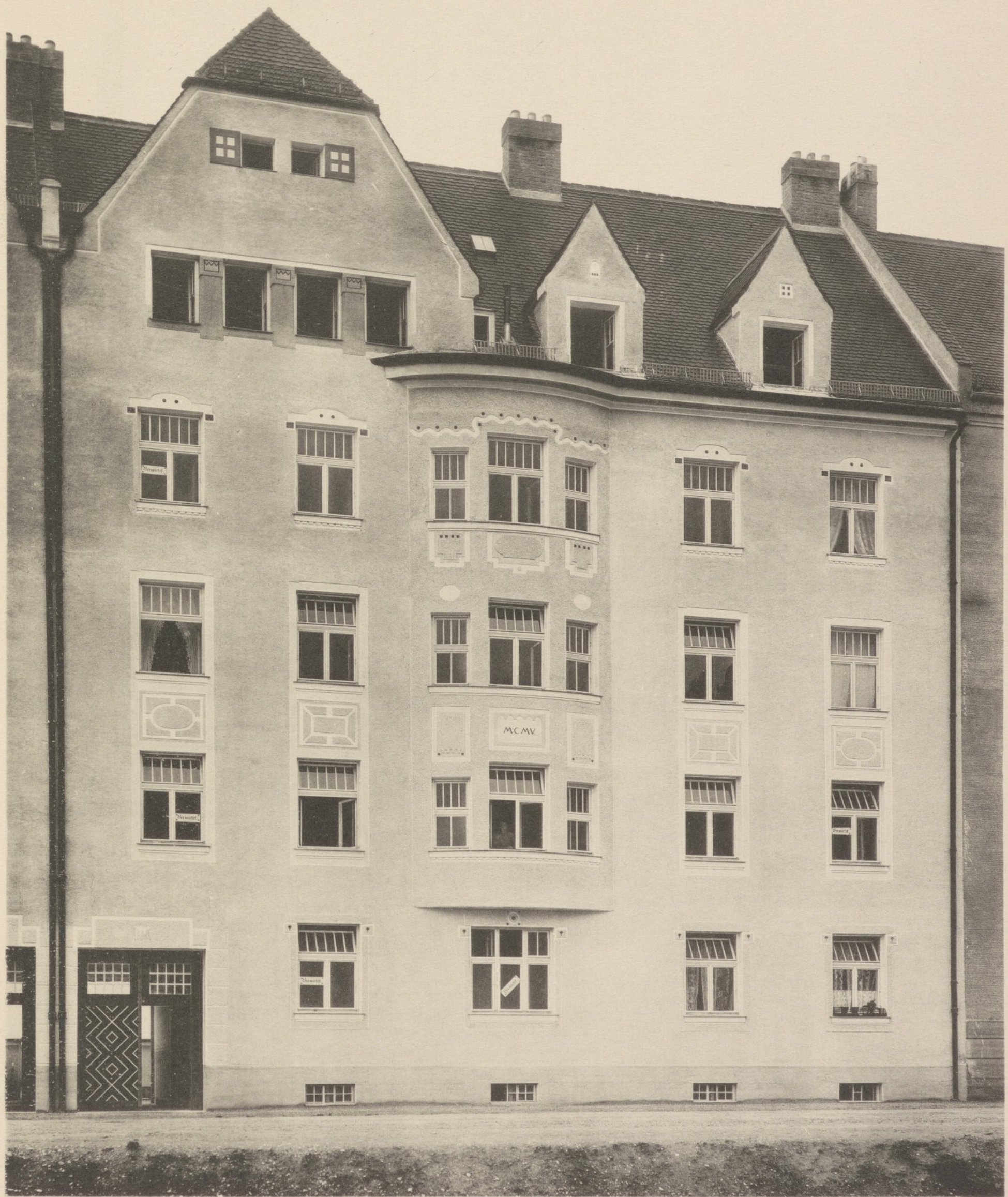
Architekt August Brüche Wohnhaus in München-Sending, Oberländerstr. 11.
