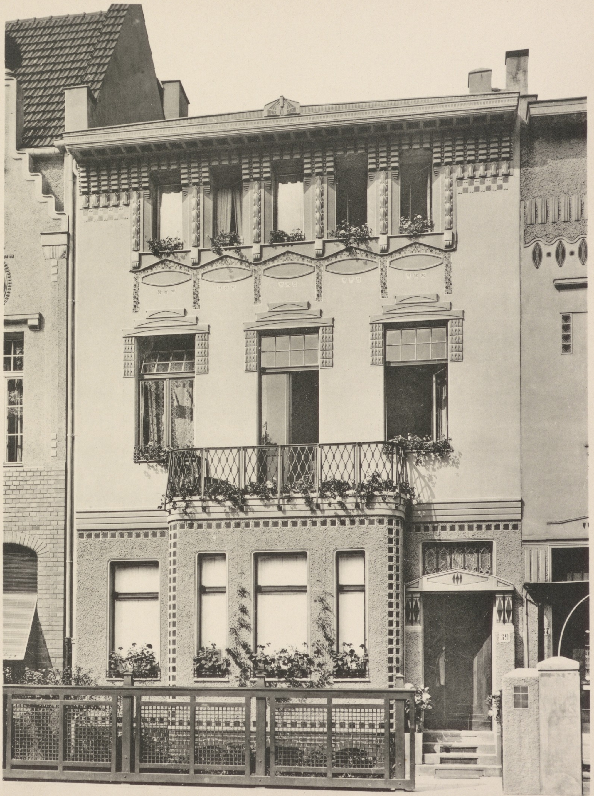
Architekt Gottfried Wehling Wohnhaus in Düsseldorf, Prinz Georgstrasse 39.
