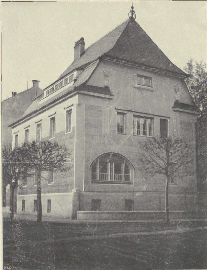
Arch. Josef Hackhofer in Wien.
