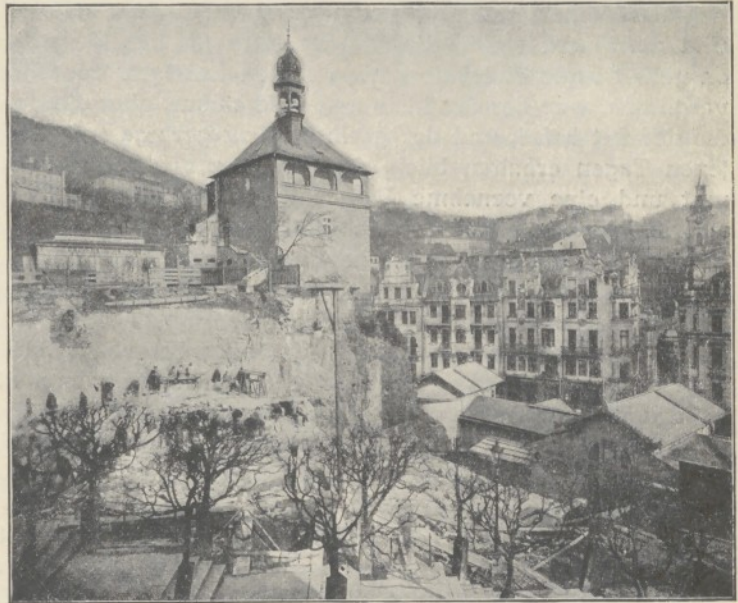
Der Stadtturm mit dem Felsbruch und dem Platz der künftigen Kolonnadenverbindung links von der Schloßbrunnkolonnade (nicht sichtbar) her, zum Marktbrunn rechts unten und um den Fuß des Stadtturms zum Mühlbrunn
