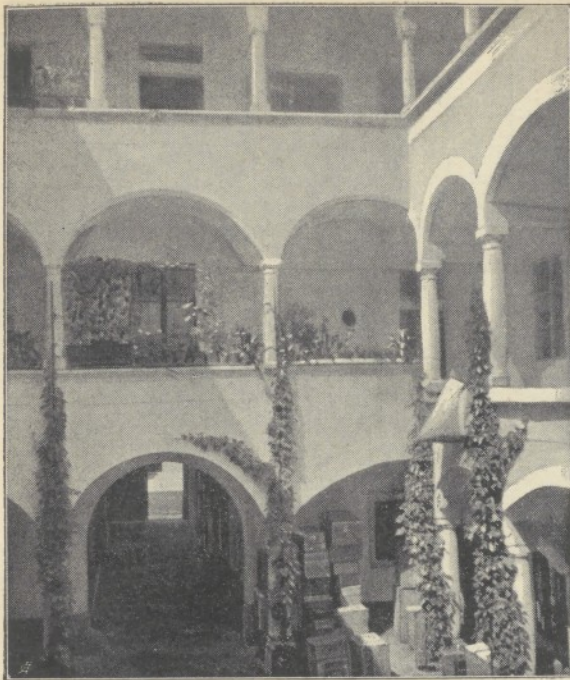
Hof eines alten Hauses.
