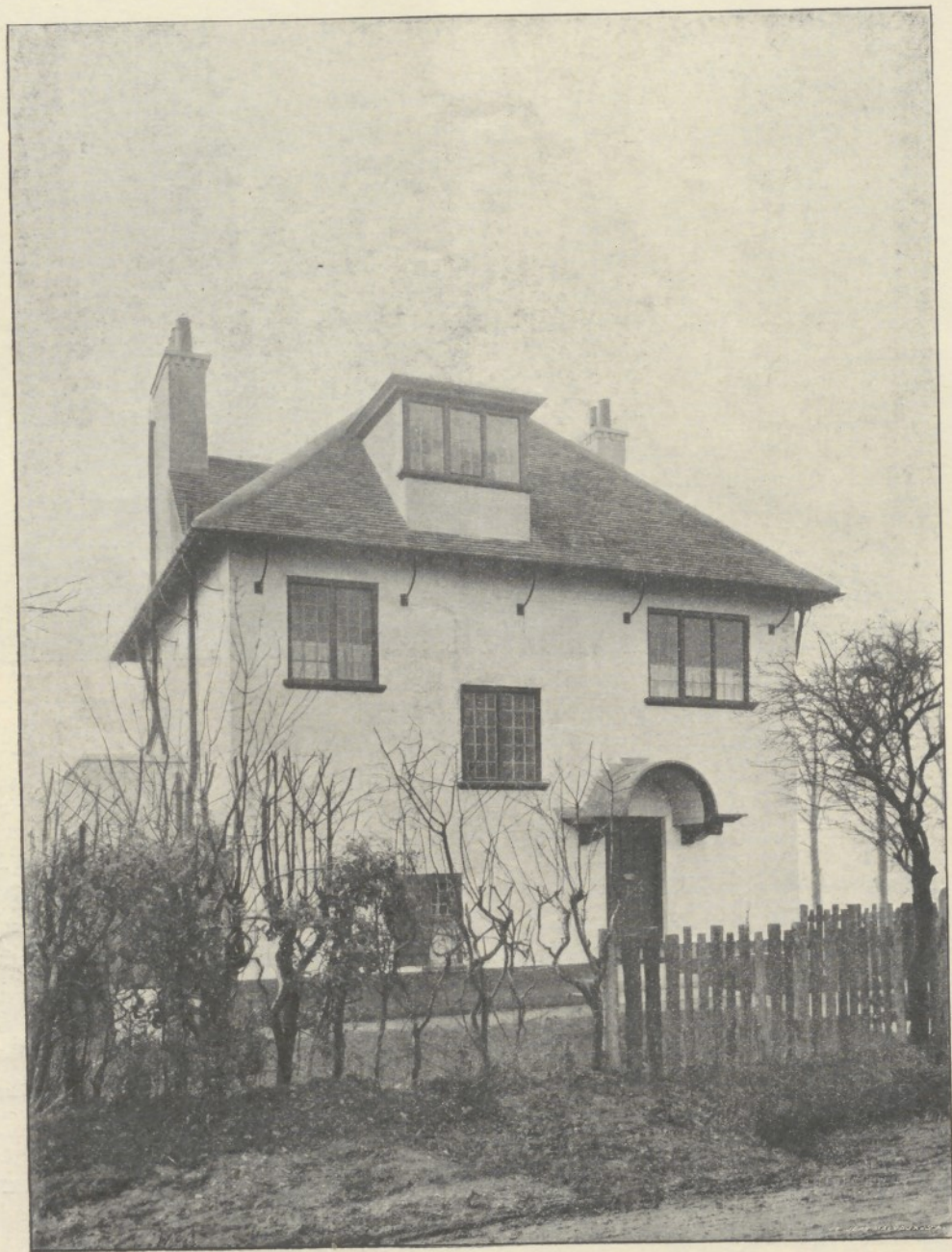
Wohnhaus in der Tennal Road, Bournville, Vorderseite. Architekt W. A. Harvey.
