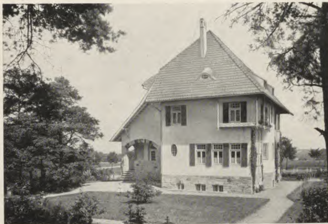
ARCH. H. DISTEL UND A. GRUBITZ B. D. A., HAMBURG HAUS K. VON MOOS IN HARBURG (BAUKOSTEN OHNE GARTEN UND UMZÄUNUNG: 44000 M. GRUNDRISSE SIEHE SEITE 59)
