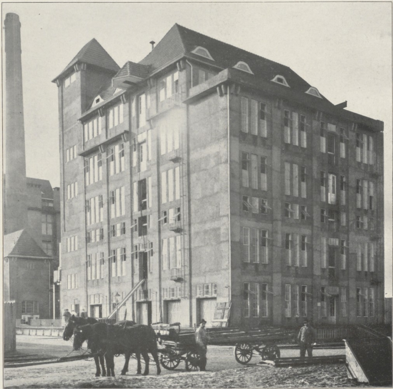
Fabrikgebäude der Kaffee-Handelsaktiengesellschaft, Bremen
