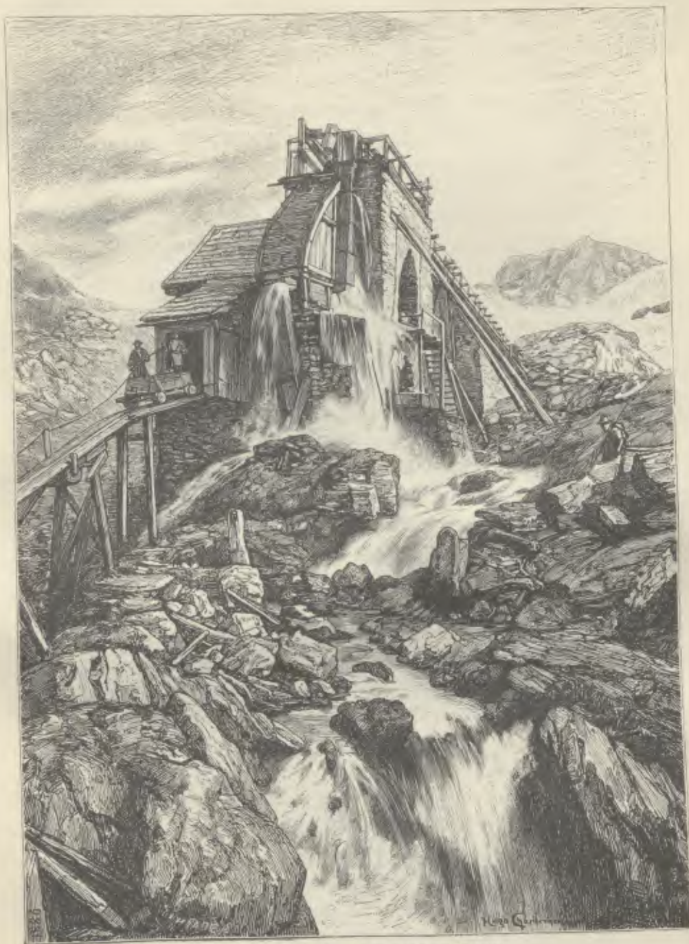
Die Förderbahn des Hauzler Bergwerkes am Goldberg.
