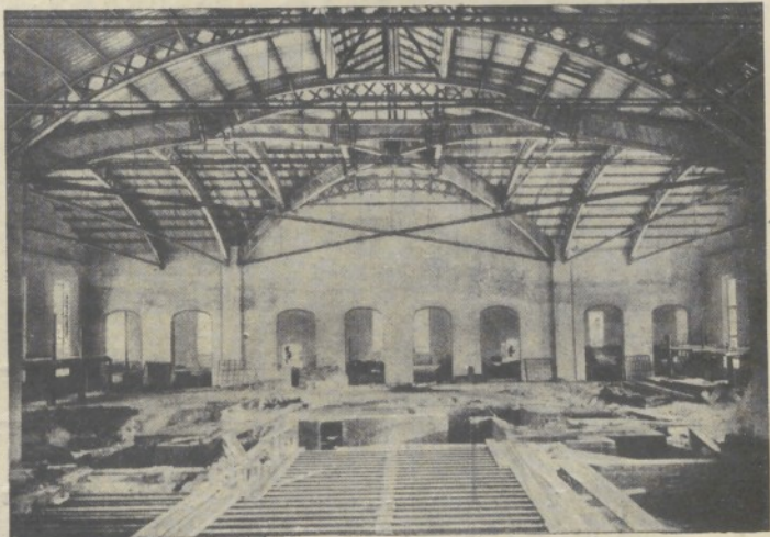
Hüttengebäude der Glasfabrik Dr. Glaser, Brüx, Binderspannweite 40 m
