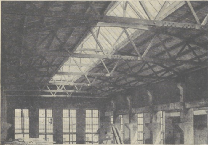
Kesselschmiede der Fa. Warchalowski, Eissler & Co., Wien, Binderspannweite 20 m
