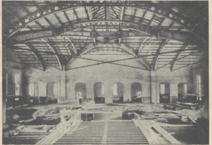
Hüttengebäude der Glasfabrik Dr. Glaser, Brüx, Binderspannweite 40 m
